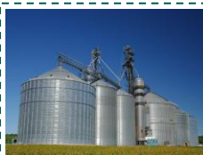
Silo vertical: metálico
