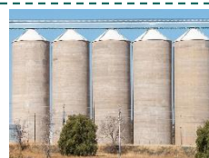
Silo vertical: concreto
